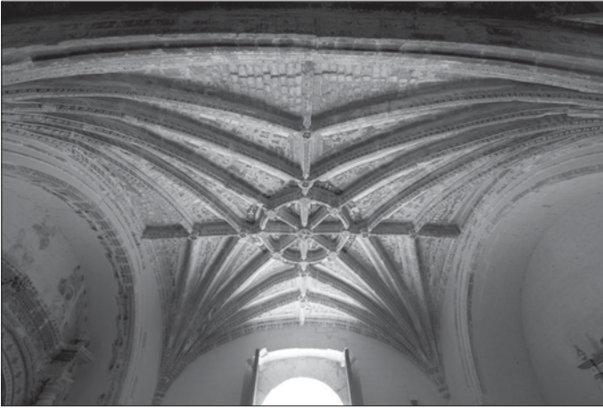
Fig. 28: Bóveda del sotocoro de Coixtlahuaca (Ibarra)
