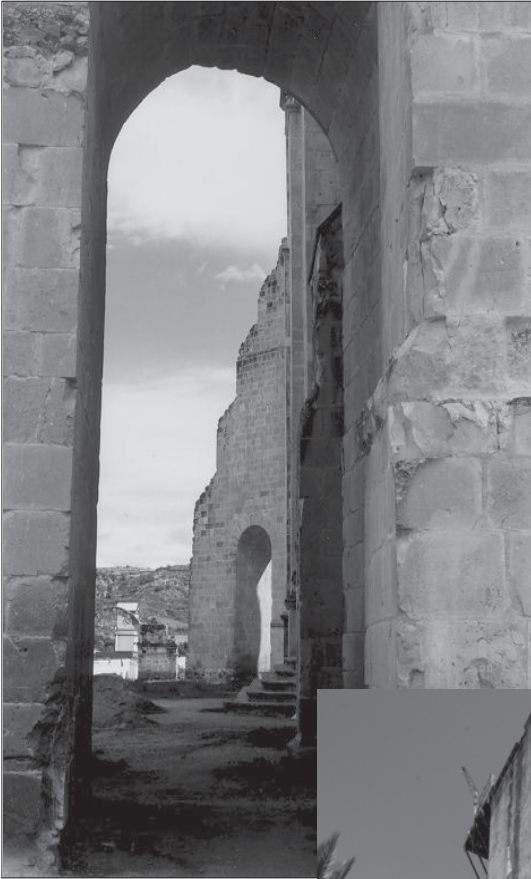
Fig. 39: Contrafuertes como «pasillos» en Yanhuitlán (Barajas)
