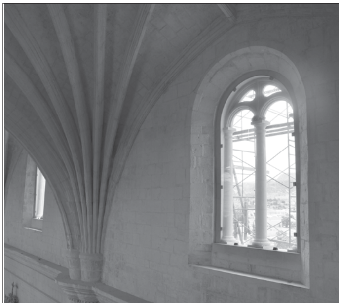
Fig. 36: Ventana «ajimezada» en la nave de Yanhuitlán (Ibarra)
