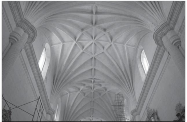
Fig. 29: Bóvedas de la nave de Yanhuitlán (Ibarra)
