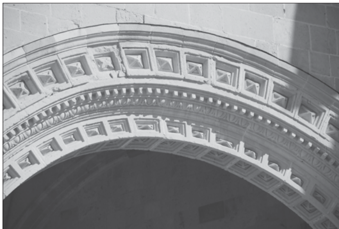
Fig. 51: Detalle que muestra la ornamentación arquitectónica en Teposcolula (Ibarra)
