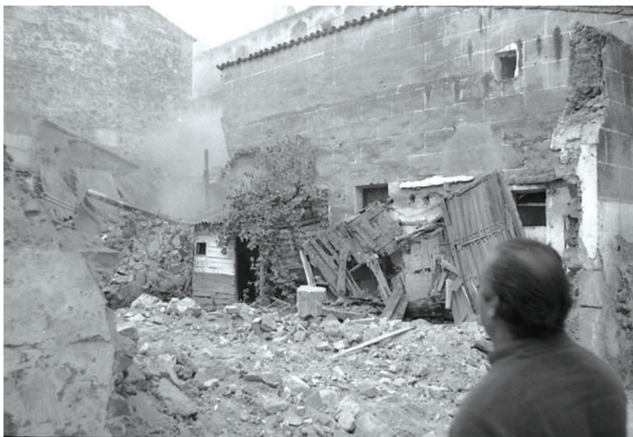
Figura 28. Detalle de las obras ejecutadas en 1973
