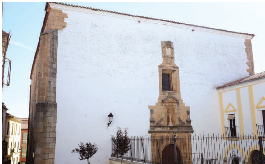
Figura 7. Fachada principal de la iglesia
