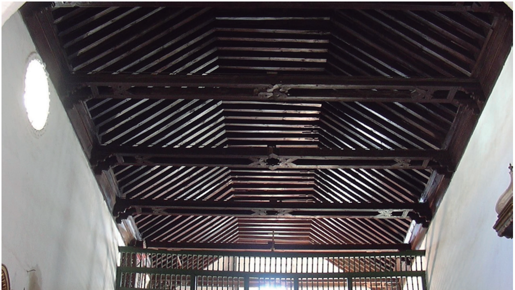
Fig. 8. Armadura de la nave.
