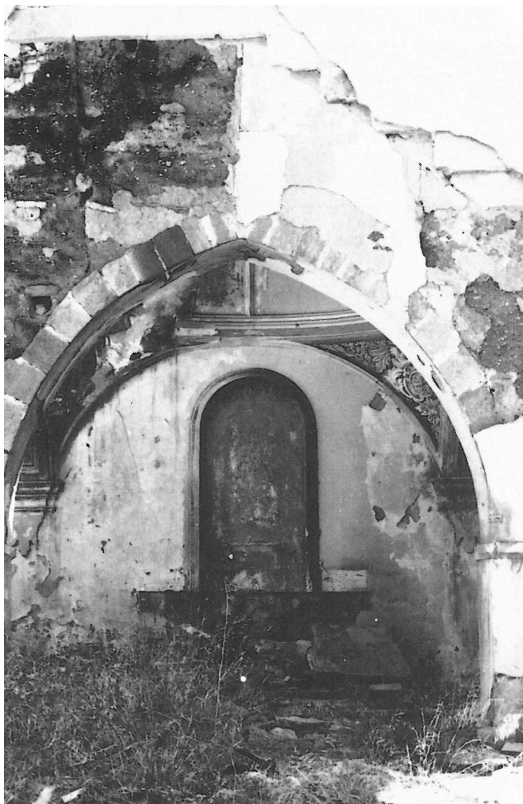
Figura 13. Detalle de las ruinas de la nave de la iglesia de Tobaruela en donde se puede apreciar un arco ojival de cantería. Este arco es impensable que se pudiera repetir como elemento constructivo esencial o como parte sustentante de las techumbres, en época posterior a la erección del primer templo gótico. Es decir, se trataría de un elemento perteneciente a la primitiva iglesia levantada en la transición de los siglos XV-XVI. (Foto de Alfonso González Palau. Año 1989)
