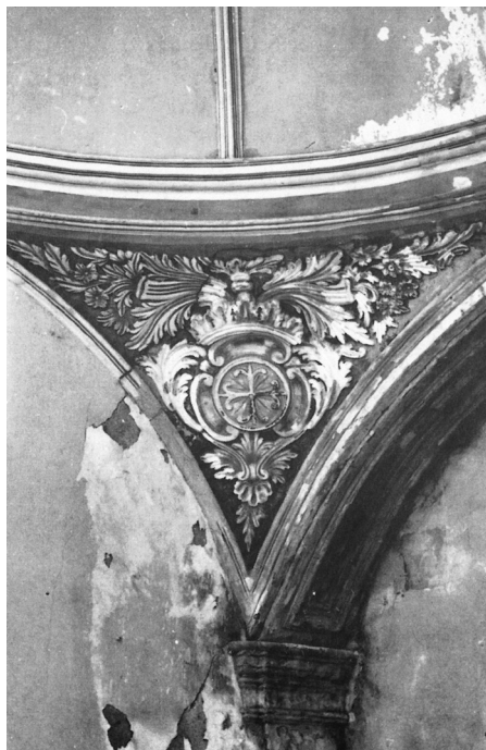
Figura 12. Detalle de una de las pechinas que sustentaban la cúpula y que estaba decorada con yeserías de motivos florales. En el centro de la misma se aprecia el escudo o sello de Santo Domingo, cuyo elemento fundamental es el llamado liliatum. (Foto de Alfonso González Palau. Año 1989)
