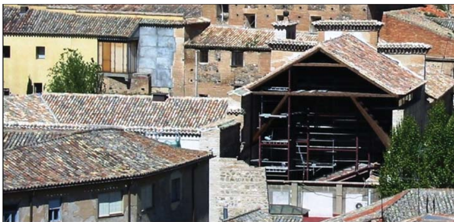
Fig. 5: Vista de la antigua iglesia del monasterio durante su rehabilitación
