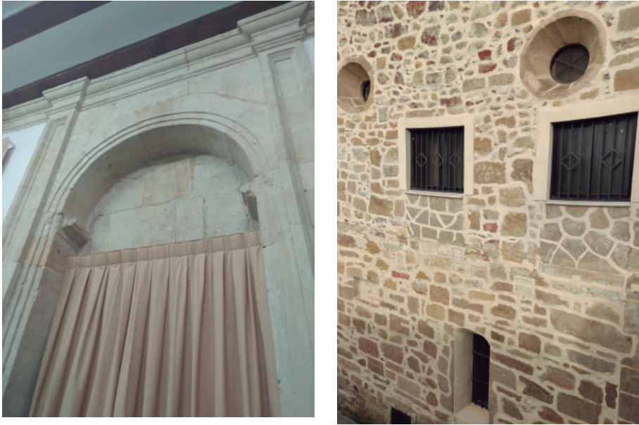
Fig. 17. Estructura del altar de piedra en el muro sur del actual Archivo Histórico de Dominicos de la Provincia de Hispania y depósito superior en el convento de San Esteban de Salamanca, principios del siglo XVII. Detalle del muro exterior. Fotografías del autor.
