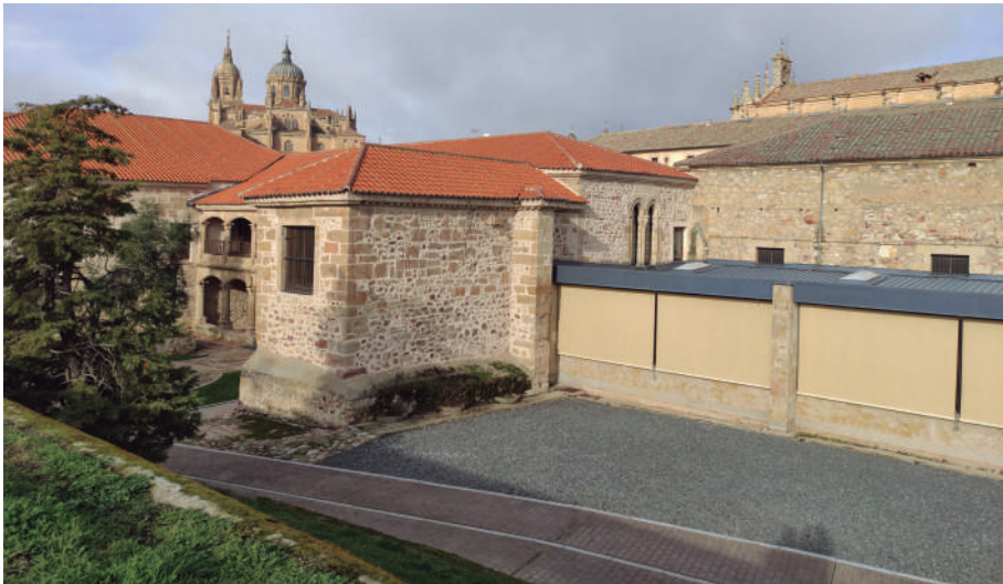
Fig. 15. Zona de la antigua enfermería. Estructura este en la que se observan dos arcos apuntados. Fotografía del autor.
