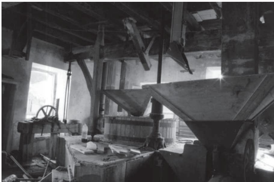
Estado actual de la Aceña de Zorita Foto: Juan José Olivera Sánchez
