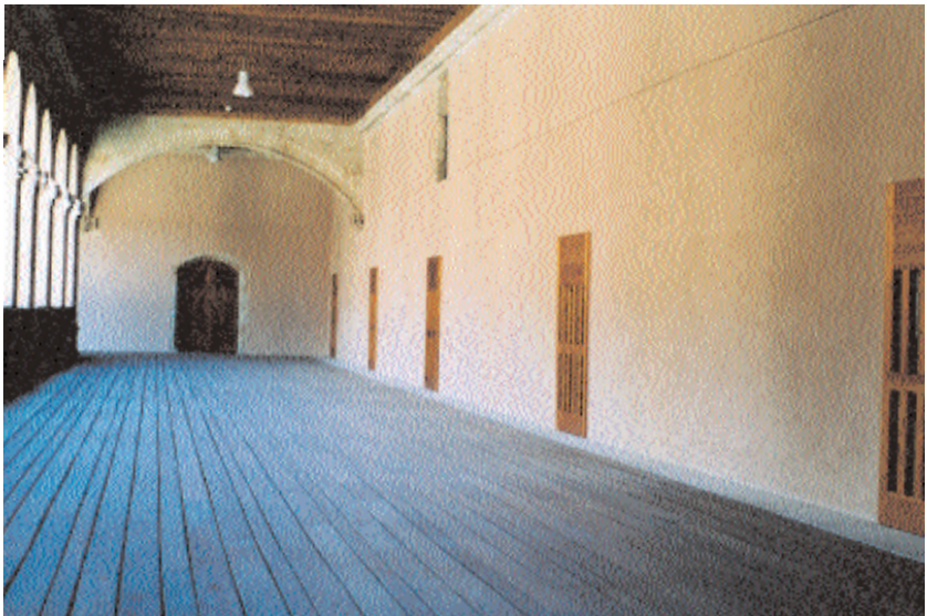
Claustro alto de los Reyes. Lado N. Con las ventanas descubiertas tapadas con celosía. Obsérvese el nuevo piso de madera
