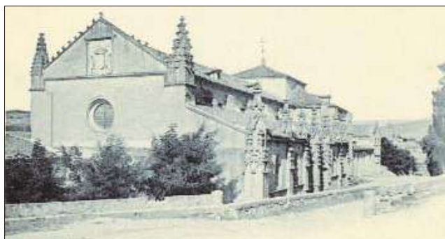
Fig. 6. Fachada occidental y lado meridional de la iglesia. Foto: Laurent, 1901. Col. Juan Francisco Sáez Pajares
